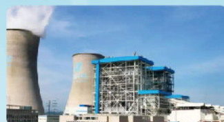
供热系统实时监控和维护
